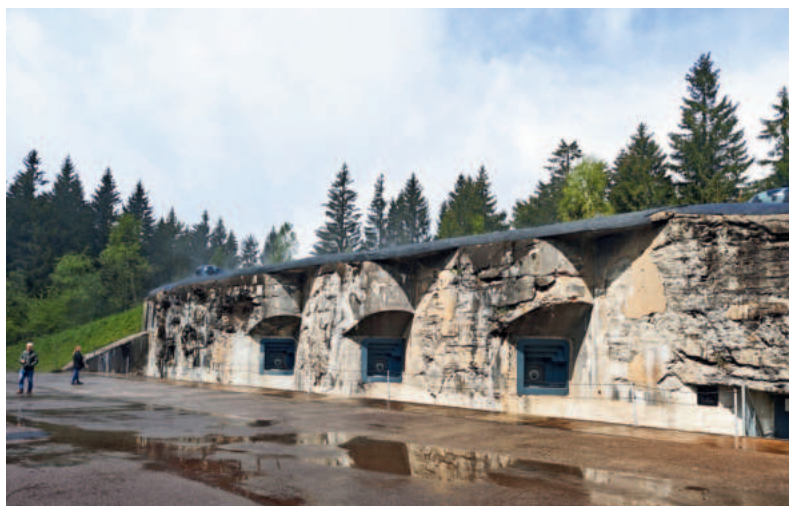
Tvrz Hanička – průčelí dělostřeleckého objektu se stopami po testování německých střel.
